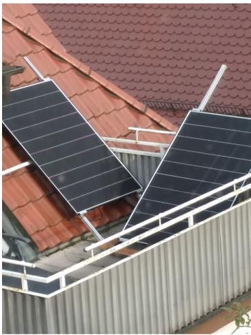
Das sind kleine Photovoltaik-Anlagen, die am Balkon oder auf der Terrasse installiert werden können. Über die Steckdose wird der erzeugte Strom direkt in das Wohnungsnetz eingespeist und verbraucht. Balkonmodule sind meist langlebig und wartungsfrei. Ihre Leistungsfähigkeit bleibt allerdings deutlich hinter Dachanlagen zurück. Trotzdem können sie bei richtiger Standortwahl zu einer erkennbaren Stromeinsparung und weniger CO<sub>2</sub>-Emissionen führen. *Logr*
