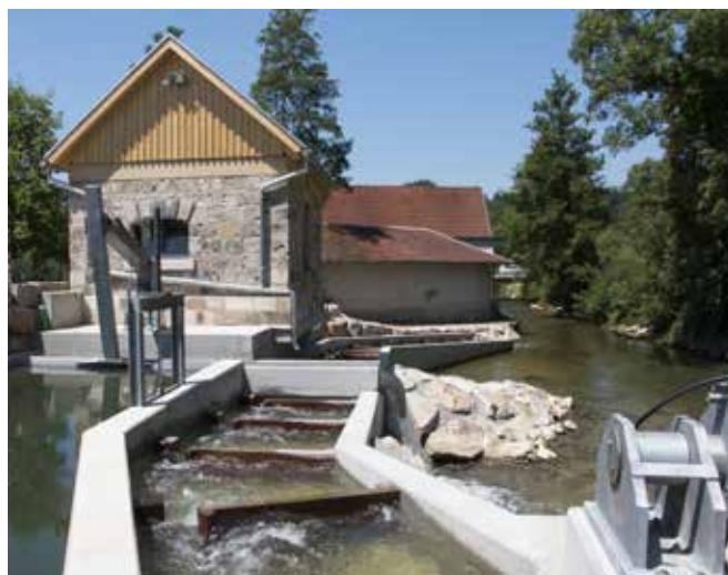
Neu errichtete Wasserkraftanlage an der Erms mit 65 kW Leistung
