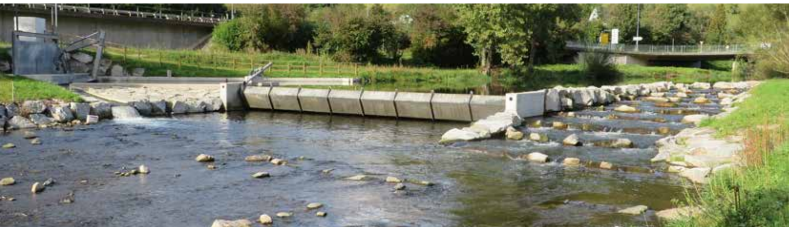
Links im Bild ist ein Bypass für den Fischabstieg zu sehen, rechts im Bild eine Fischtreppe für den Fischeaufstieg (Kinzig).
