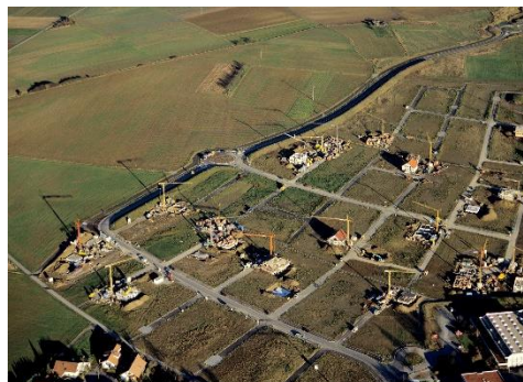
Einfamilienhausgebiet in Gärtringen
