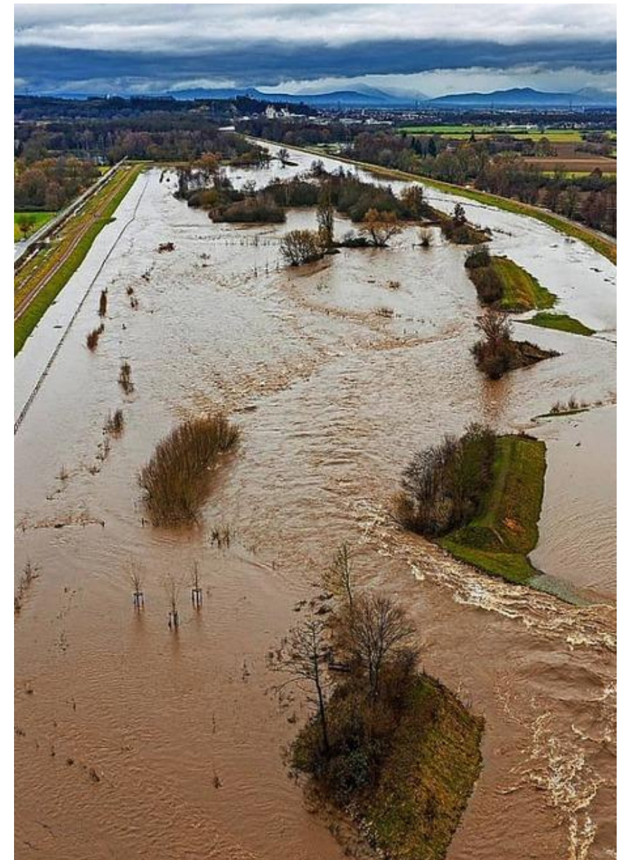
Renaturierung der Elz bei Köndringen, Hochwasser 4.2.2020. Foto: LRA EM
